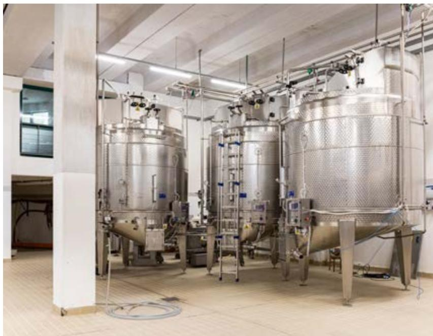
**Le superfici dei pavimenti sono state realizzate in ceramica industriale e anche i fermentatori, in acciaio Aisi 316, consentono il mantenimento di un elevato livello di igiene e pulizia**
